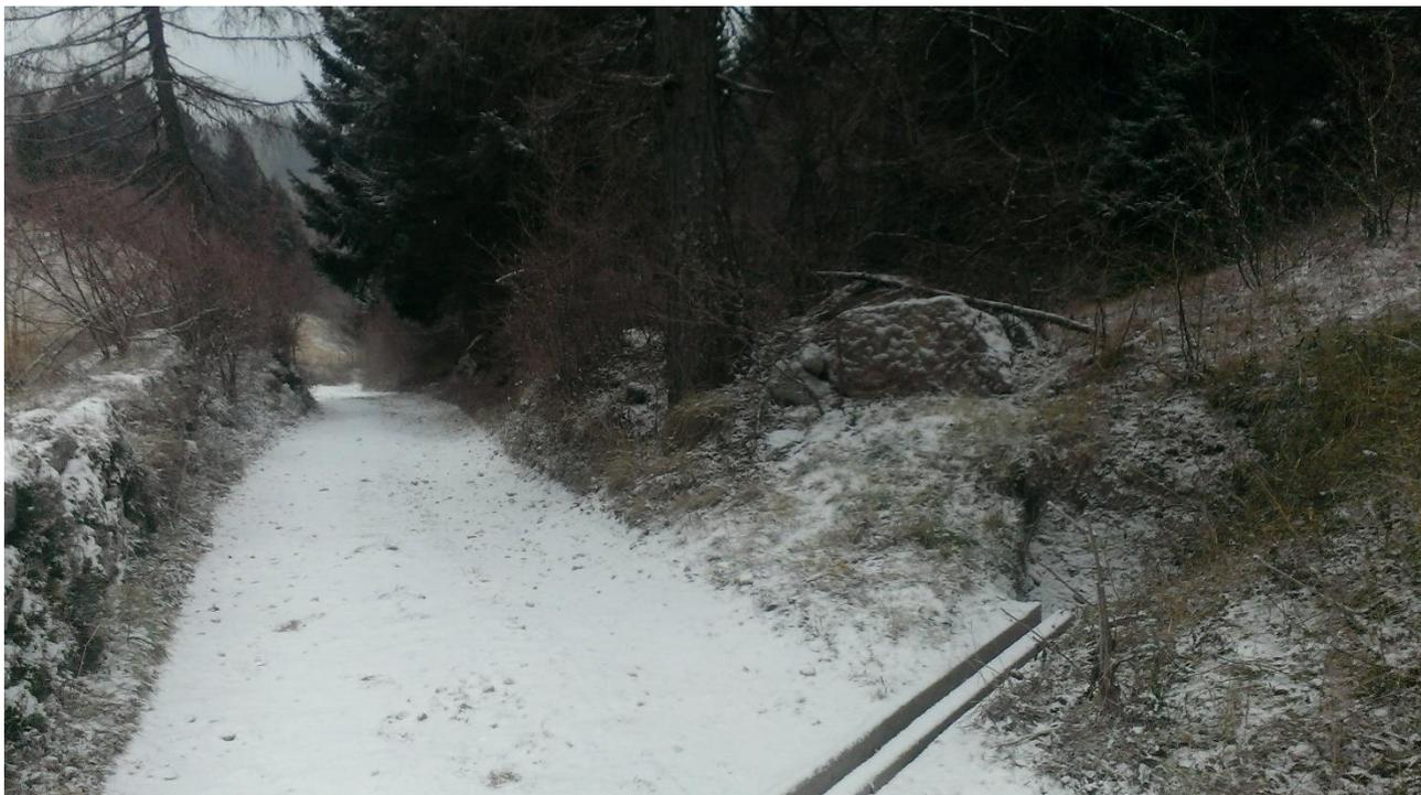
*Figura 11. Particolare di canalette in legno con buche per lo scarico delle acque*
