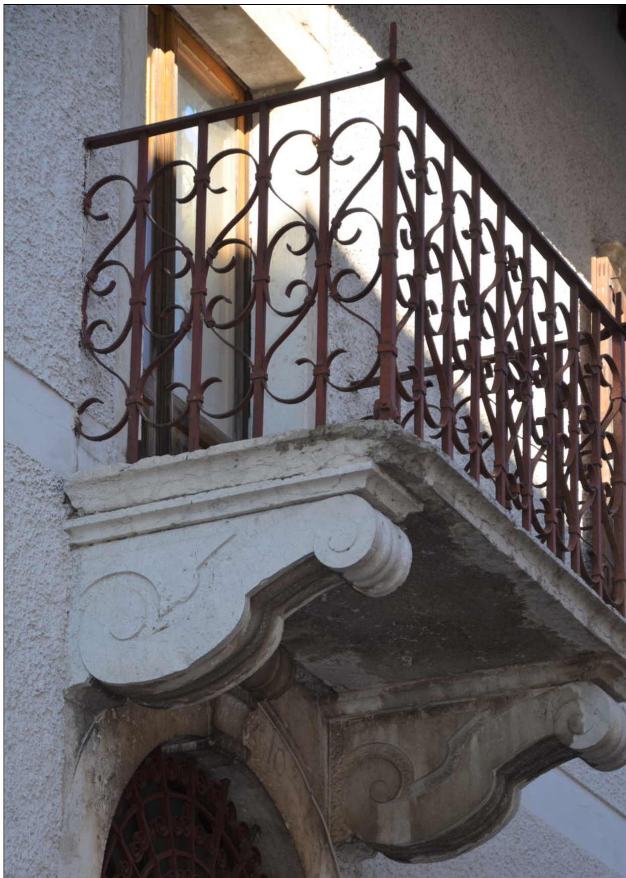
BALCONE CON RINGHIERA IN FERRO LAVORATO
