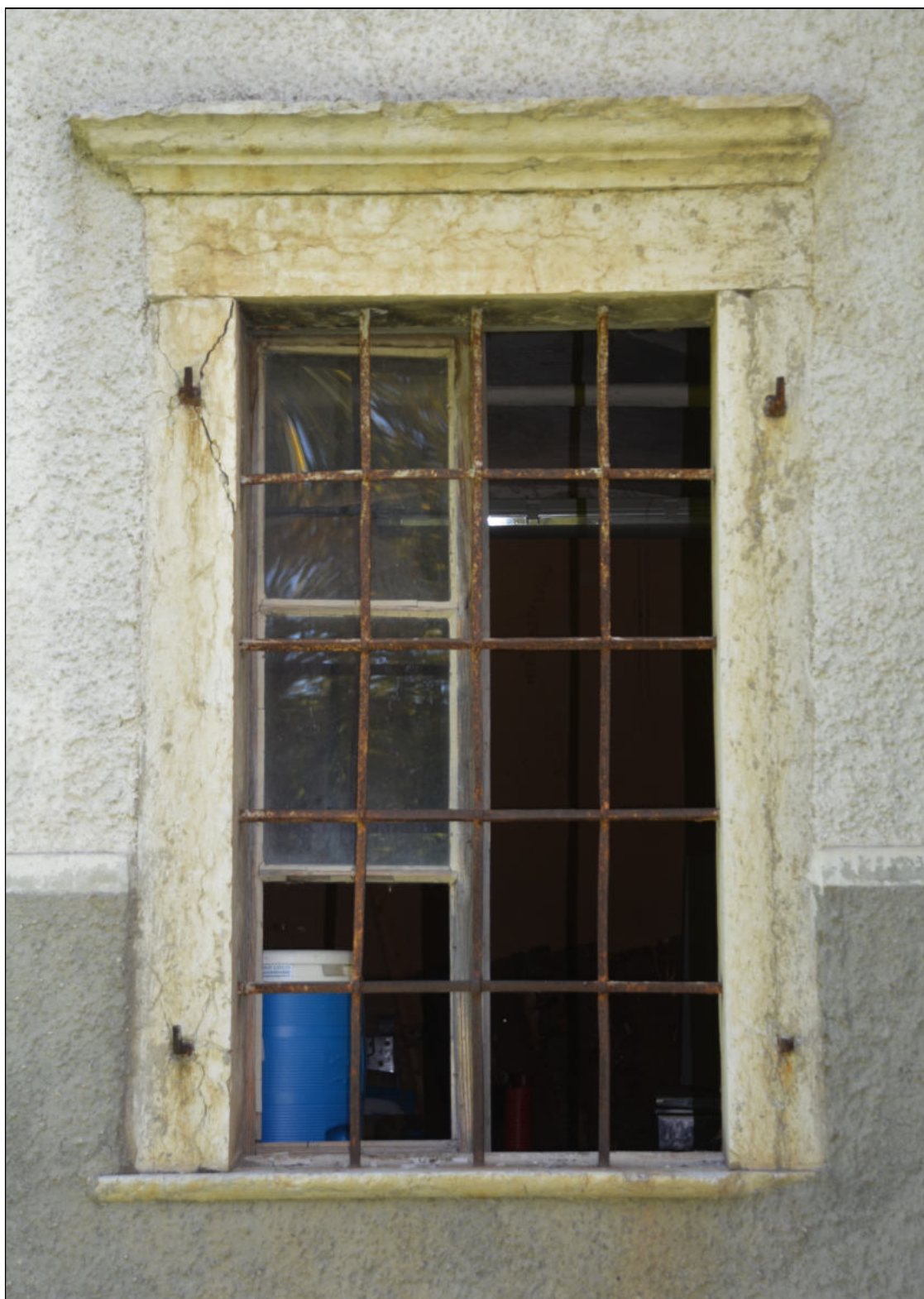
CONTORNO FINESTRA IN PIETRA LAVORATA
