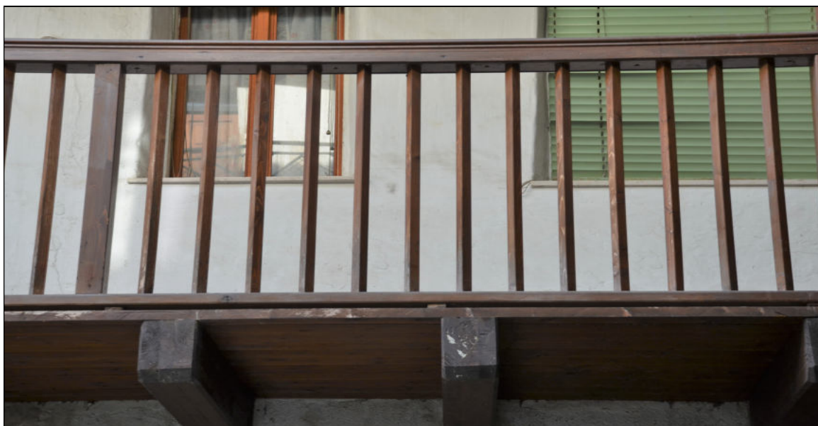
POGGIOLI CON PARAPETTI IN LEGNO A FILETTI VERTICALI
