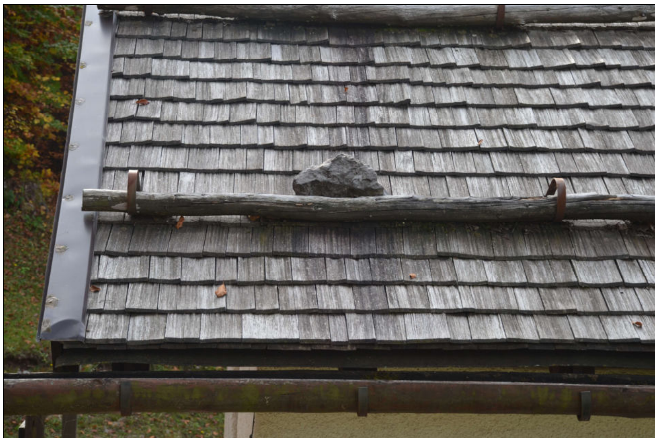
CORRENTI IN LEGNO PASSANTI FRA I FERMANEVE SU TETTO IN SCANDOLE
