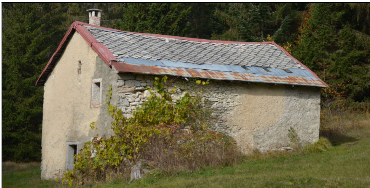
QUADRELLE IN CEMENTO POSATE SULLA COPERTURA DI EDIFICI STORICI SPARSI
