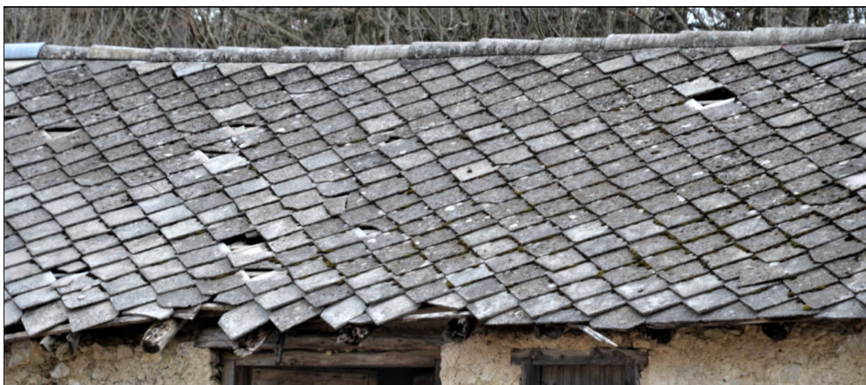
QUADRELLE IN CEMENTO POSATE SULLA COPERTURA DI EDIFICI STORICI SPARSI
