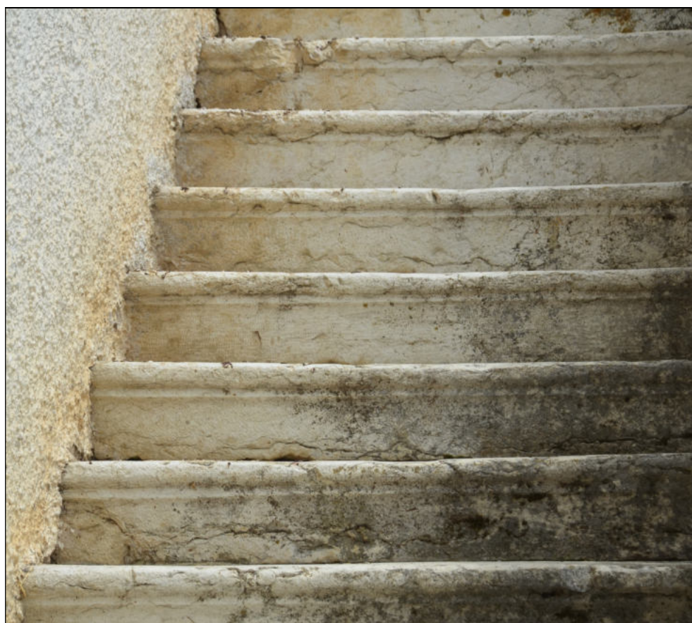
SCALA ESTERNA IN MURATURA CON SCALINI IN PIETRA
