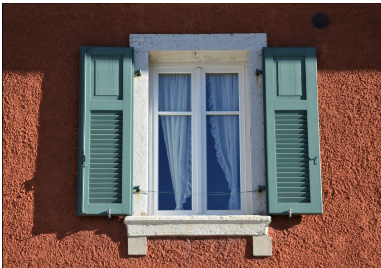
SERRAMENTI FINESTRE IN LEGNO A DUE ANTE E QUATTRO SPECCHI
