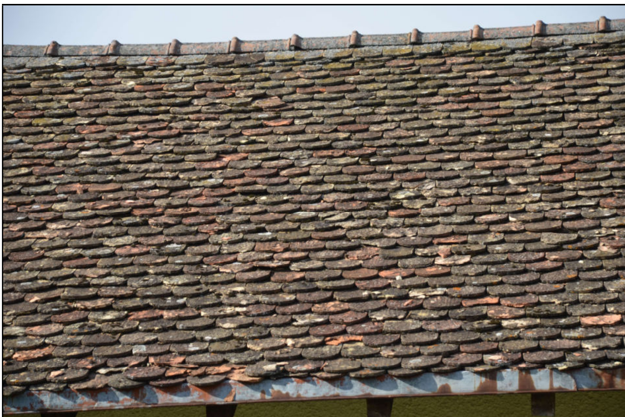
TEGOLE IN COTTO A “CODA DI CASTORO” POSATE SU EDIFICI STORICI SPARSI
