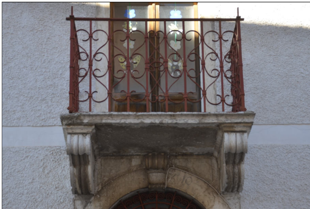
BALCONI CON RINGHIERA IN FERRO LAVORATO
