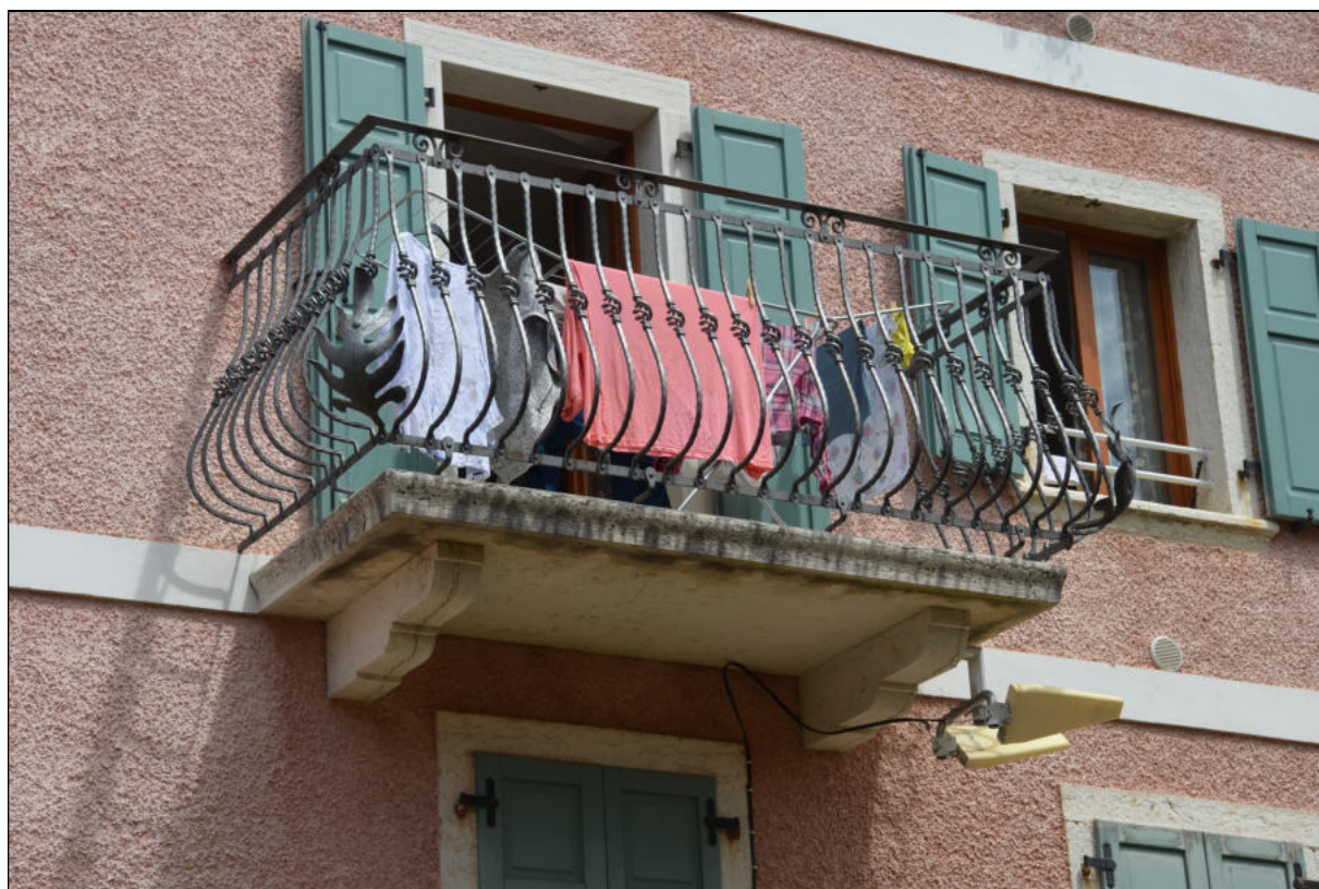
BALCONI CON RINGHIERA IN FERRO LAVORATO
