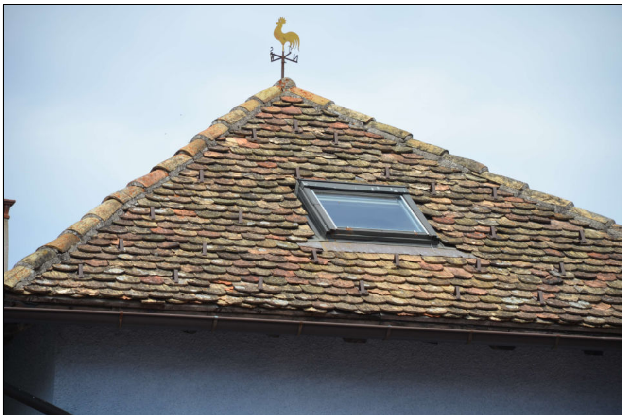
MANTO DI COPERTURA IN COTTO A “CODA DI CASTORO” POSATO SULLA COPERTURA DI UN EDIFICIO DEL CENTRO STORICO DI GIONGHI
