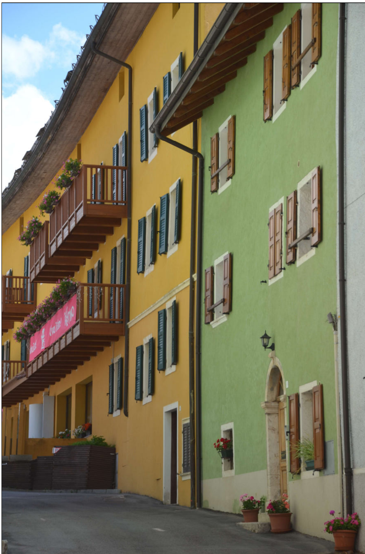
INTONACI DI MALTA DI CALCE AL LISCIO
