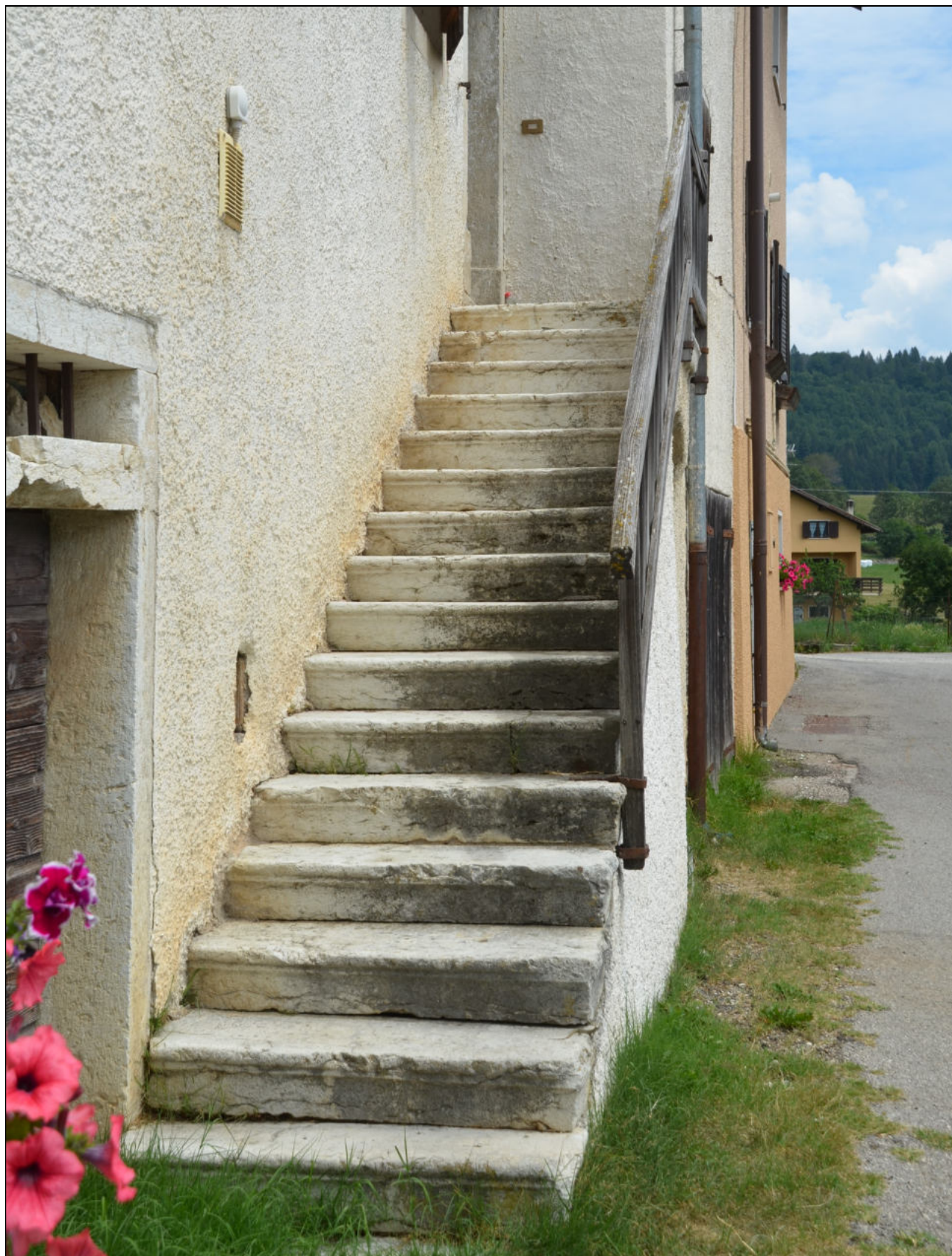
SCALA ESTERNA IN MURATURA CON SCALINI IN PIETRA
