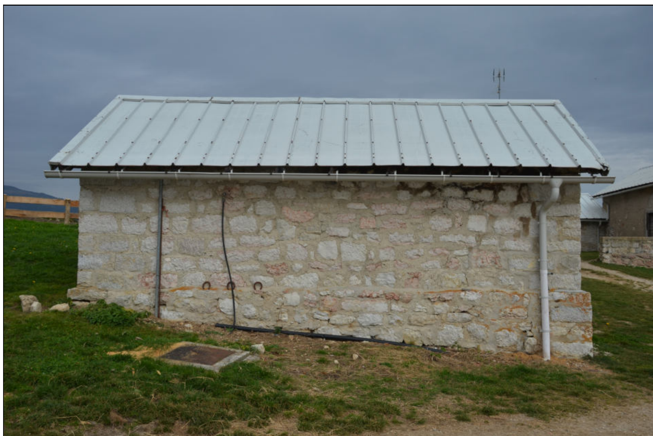
LAMIERA GRECATA POSATA SULLA COPERTURA DI EDIFICI STORICI SPARSI
