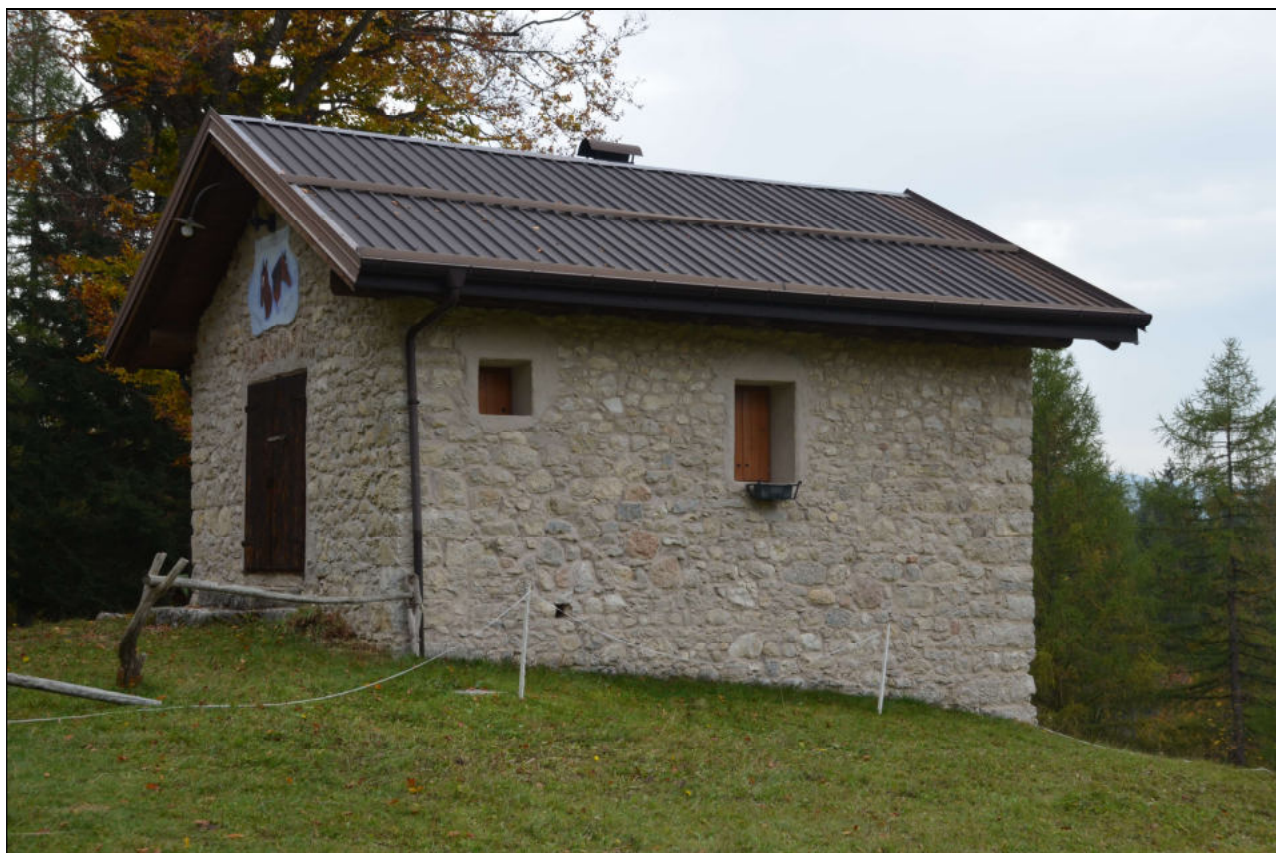
LAMIERA GRECATI POSATA SULLA COPERTURA DI UN EDIFICIO STORICO SPARSO
