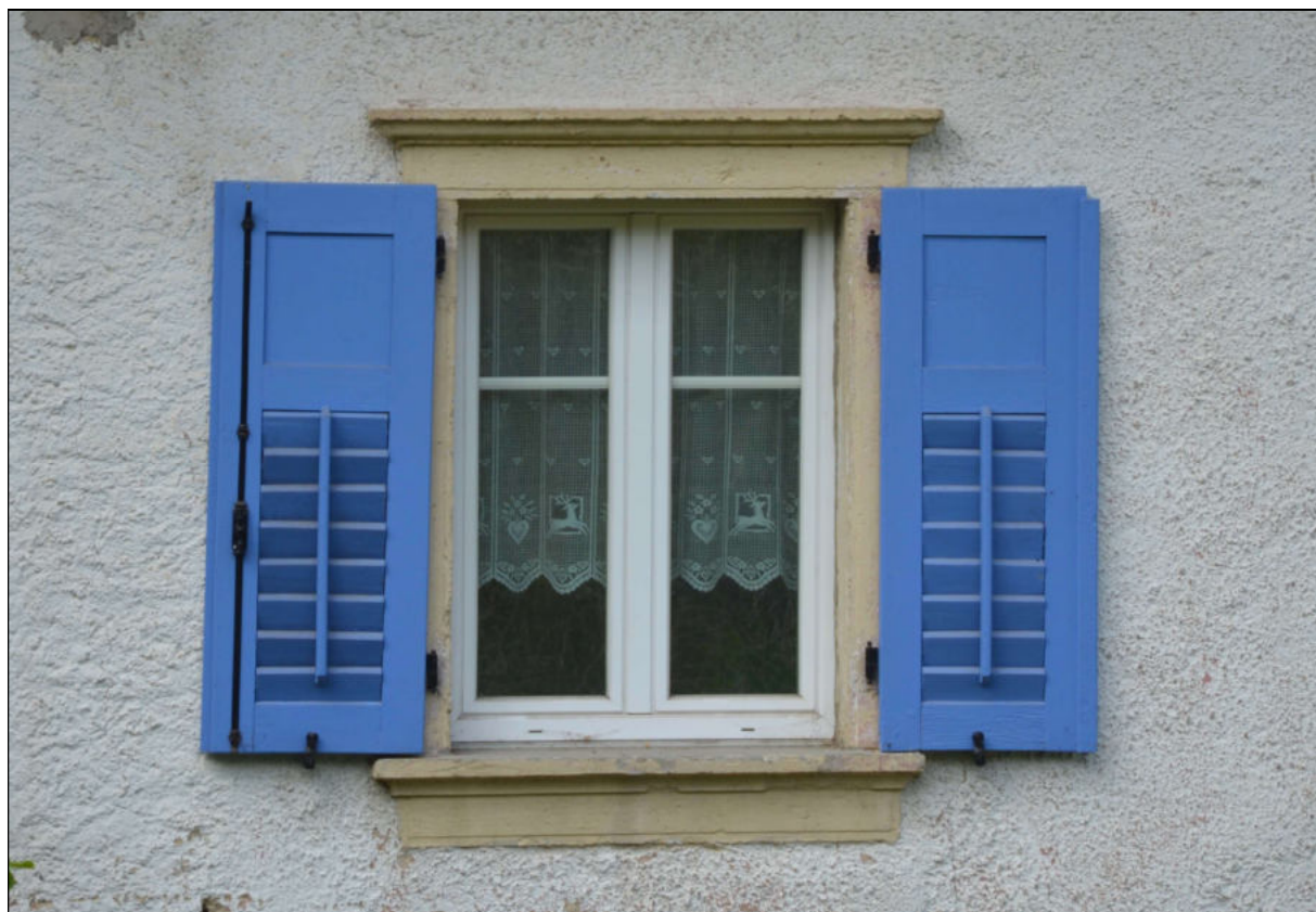
SERRAMENTI FINESTRE IN LEGNO A DUE ANTE E QUATTRO SPECCHI
