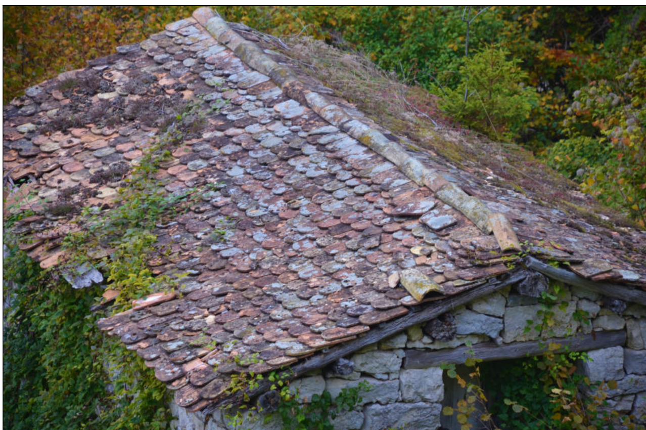
TEGOLE IN COTTO A “CODA DI CASTORO” POSATE SU EDIFICI STORICI SPARSI
