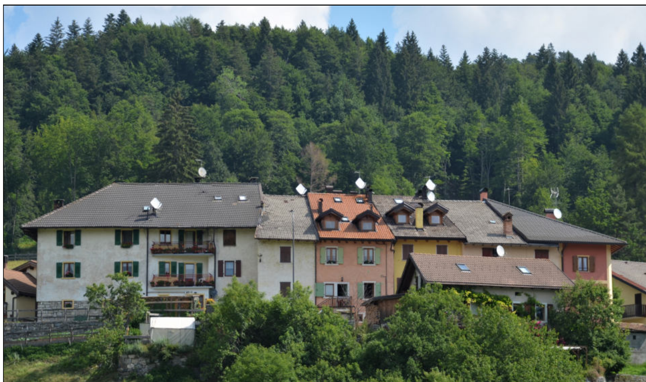
TEGOLE IN CEMENTO DI VARIE TONALITA' AFFIANCATE A TEGOLE IN COTTO (SCHIERA STORICA DI SLAGHENAUF)
