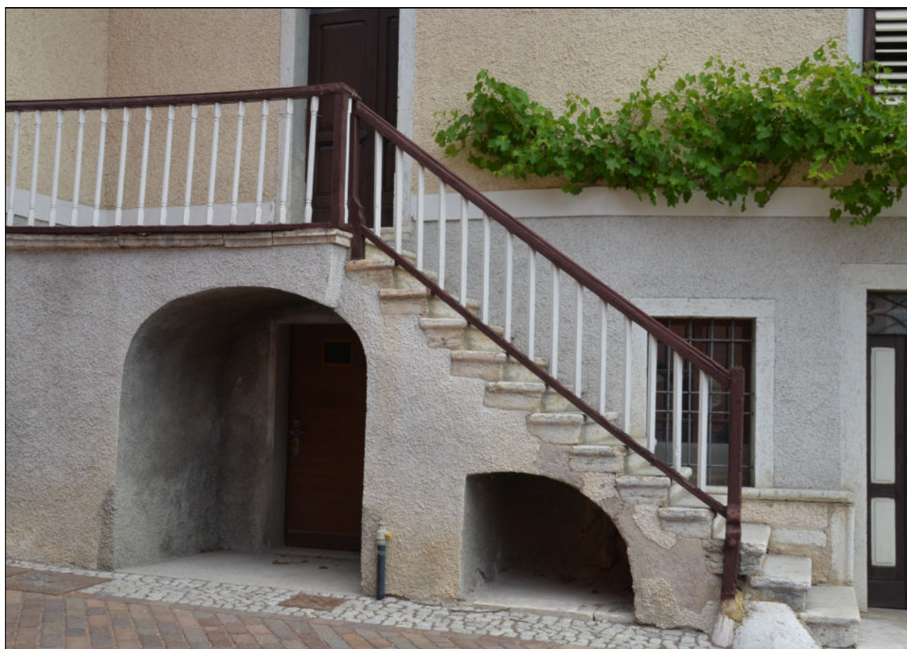
SCALA ESTERNA IN MURATURA CON SCALINI IN PIETRA
