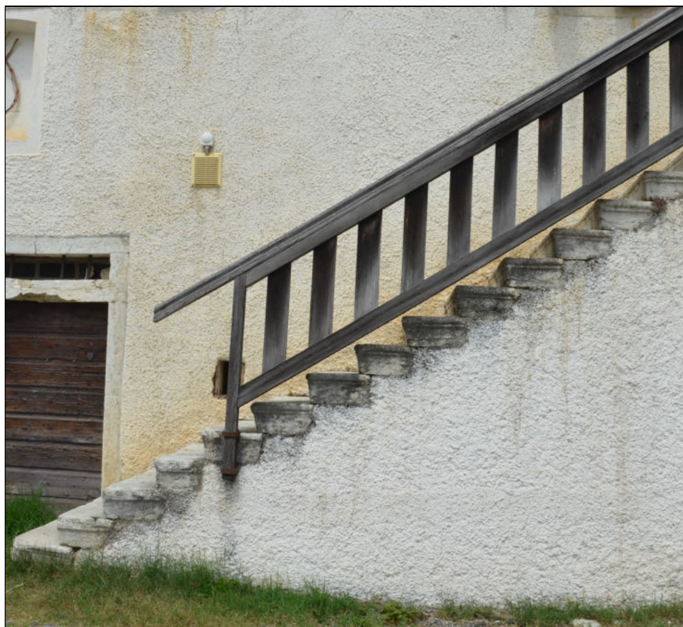
SCALA ESTERNA IN MURATURA CON SCALINI IN PIETRA
