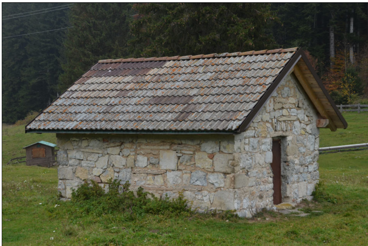
TEGOLE IN CEMENTO POSATE SULLA COPERTURA DI UN EDIFICIO STORICO SPARSO
