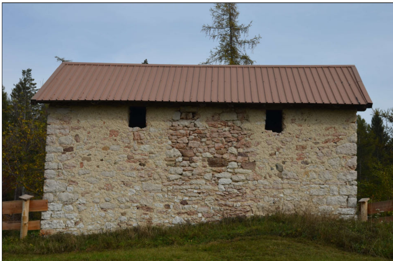
LAMIERA GRECATA POSATA SULLA COPERTURA DI EDIFICI STORICI SPARSI
