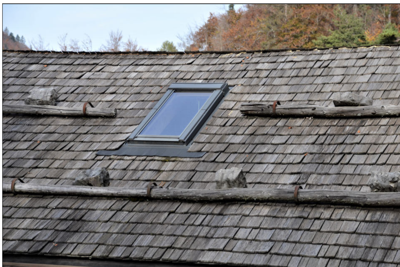
CORRENTI IN LEGNO PASSANTI FRA I FERMANEVE SU TETTO IN SCANDOLE
