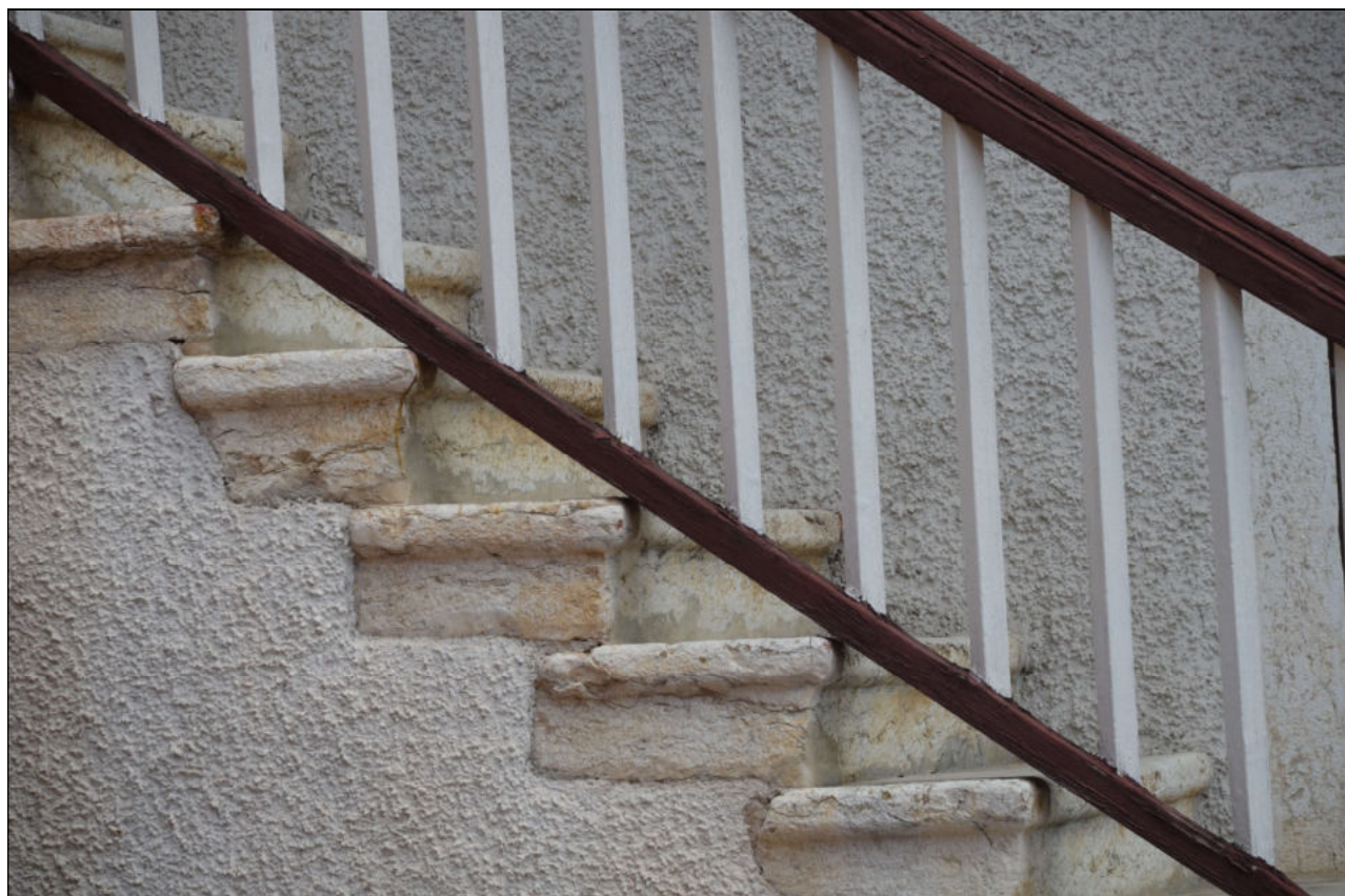
SCALA ESTERNA IN MURATURA CON SCALINI IN PIETRA
